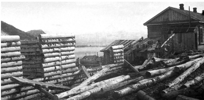
Возведение жилого дома в АКОграде
