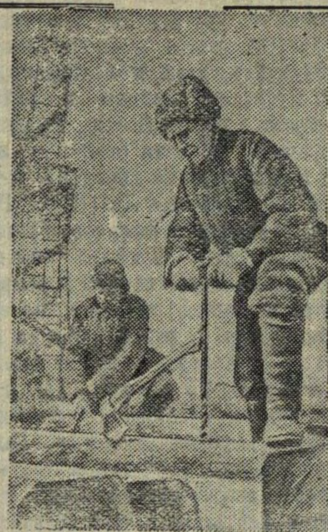
Бригада строителей вышек конторы турбинного бурения треста „Краснокамскнефть“ (Урал) закладывает новую наклонную буровую.
