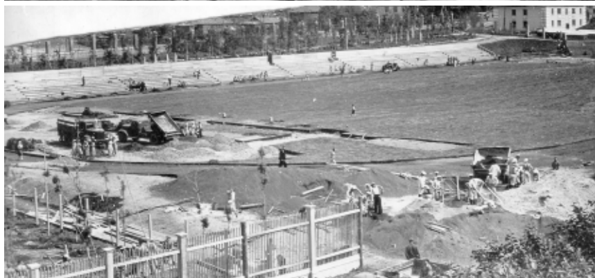
Строительство стадиона, 1959 г. [КОКМ НВФ 3149; 2644]
