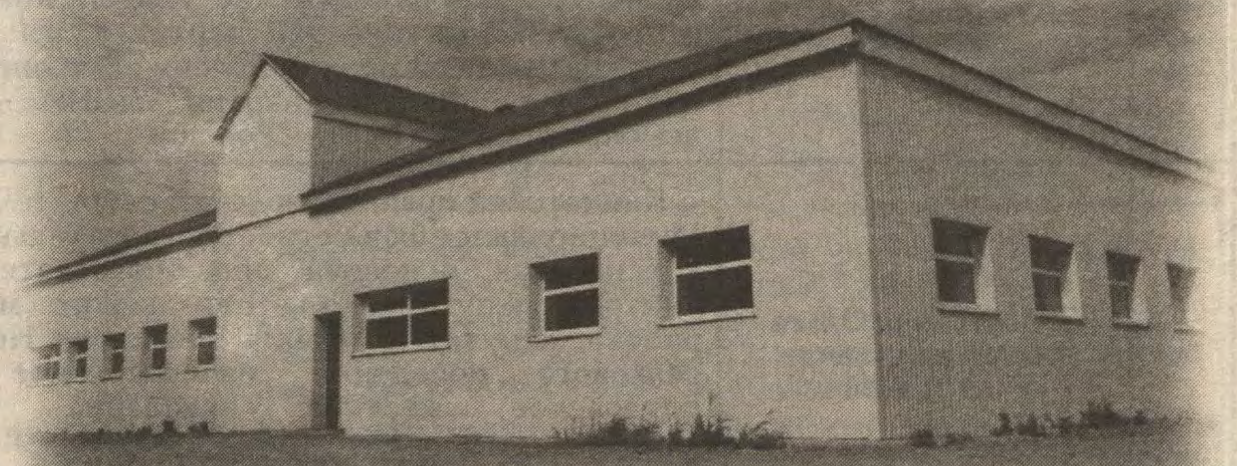
В 2014 г. в Николаевском сельском поселении завершилась реконструкция бани.
